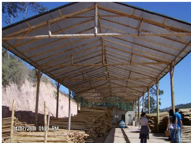
Foto 01. Layout do galpão de tratamento de madeira
