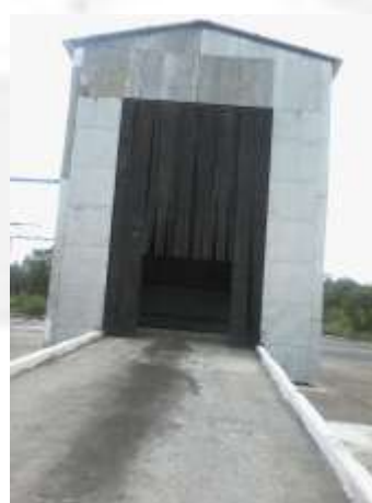
Foto 08. Segundo Sistema de Descarga de Carvão .
