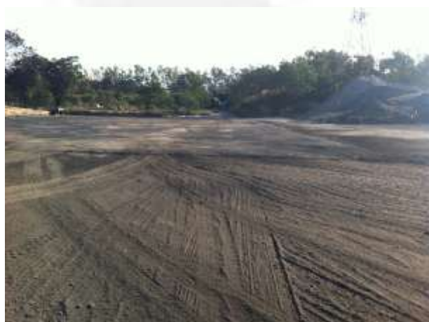
Foto 07. Área antes da Instalação do Sistema de Descarga de Carvão
