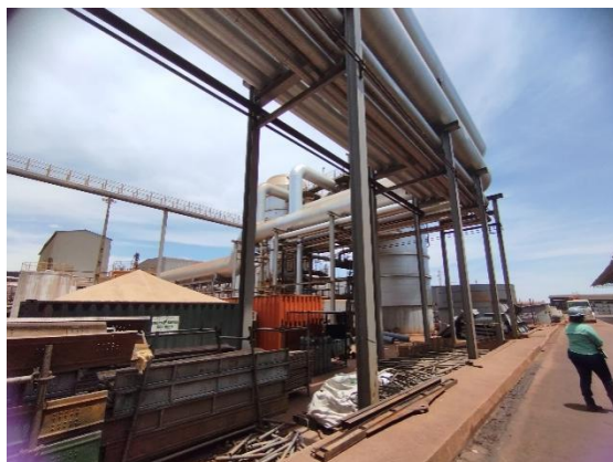
Foto 01. Equipamentos em instalação
