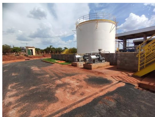
Foto 04. Pista e Tanque de combustíveis em instalação
