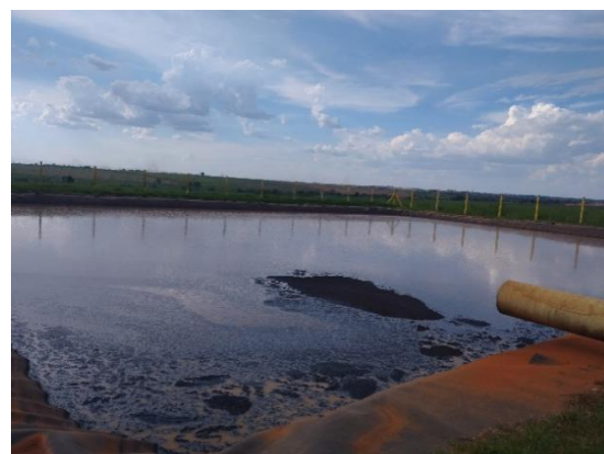
Foto 03. Tanque de vinhaça/águas residuárias
