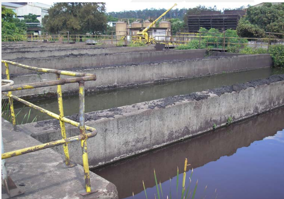
Foto 04: As câmaras (15) que formam o Tanque de Lama Mineral. Após decantação, as águas retornam à entrada da Bacia de Sedimentação, e a lama mineral é co-processada. Ao fundo, a torre de resfriamento.
