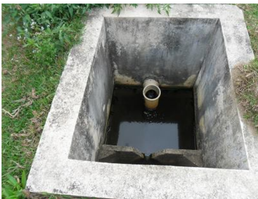
Foto 06 – Caixa de saída de efluentes da ETE.
