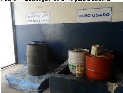
Foto 03 – Bacia de contenção de óleo usado
