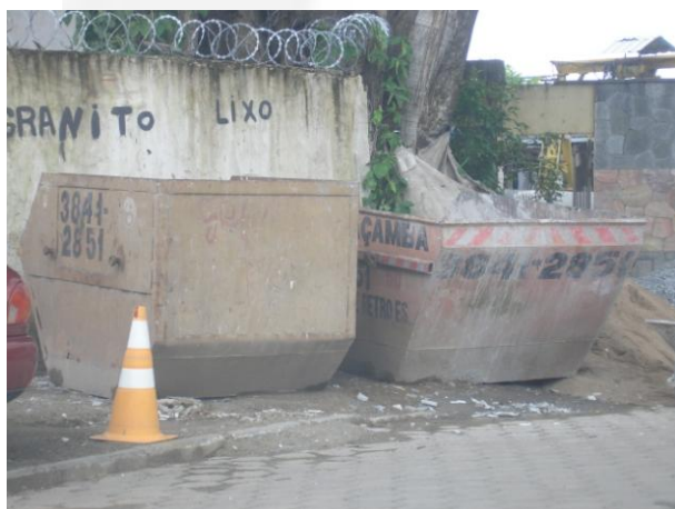
Foto 03. Caçamba para armazenamento temporário dos rejeitos e resíduos.
