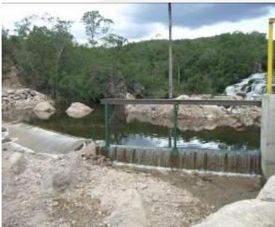
**Foto 01.** Crista do barramento e tomada d'água
