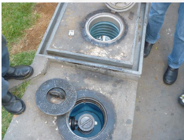
Foto 09. Armazenamento de óleo usado
