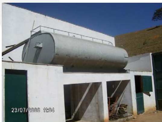
Foto 8-Reservatório aéreo de óleo combustível.
