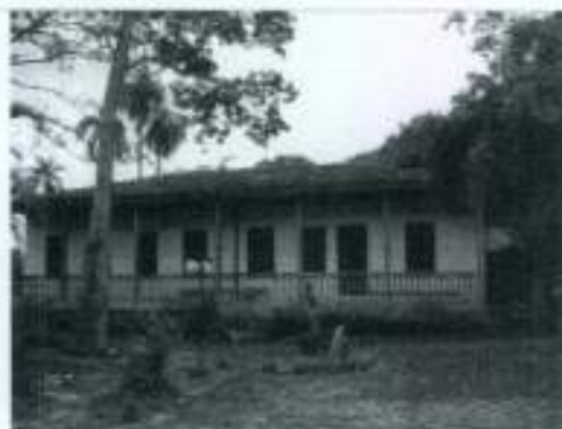
Figura 28 -Fachada da Fazenda Barroso. Foto Digital – Jan. 2013. Fonte: Luana Carla Martins Campos.
