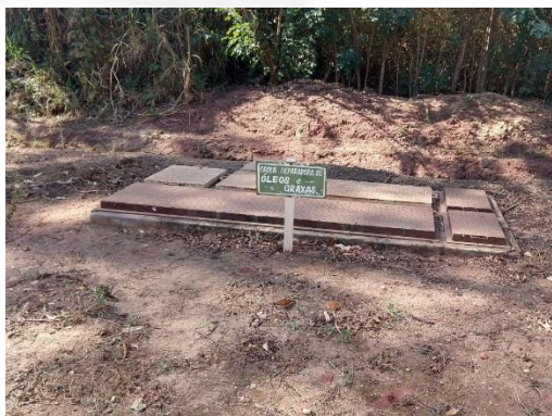
Sistema de separação de água e óleo.
