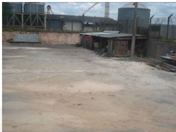
Foto 06. Local onde serão construídas duas caldeiras.
