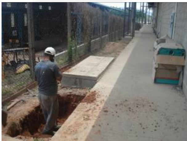
Foto 07. Local de implantação do sistema preliminar de tratamento do efluente da tinturaria.
