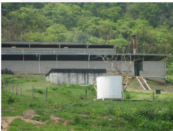
Foto 15: Visão geral da ETEI
