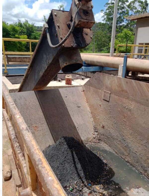
Foto 02: Areia sendo removida do desarenador e direcionada para caçamba.
