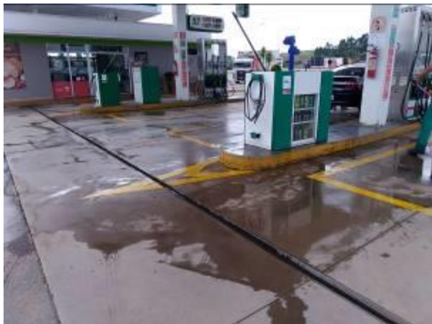
Pista de veículos leves
