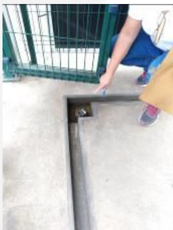
Canaletas observadas em toda a área das pistas
