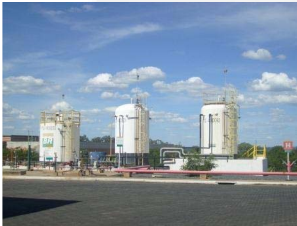
Foto 01. Tanques de armazenamento de insumos com diques de contenção
