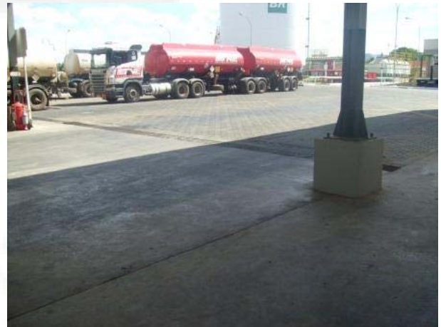
Foto 02. Drenagem pluvial a montante do pátio de descarga
