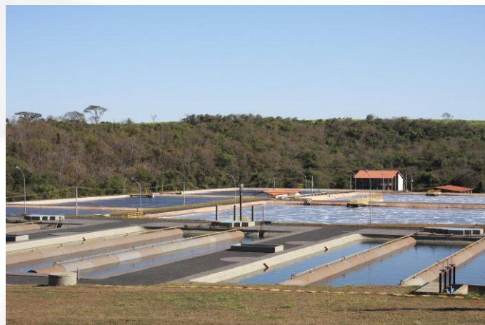
Figura 15- Reatores UASB
