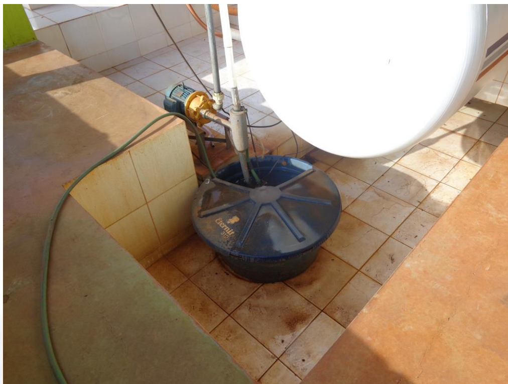
Foto 02: Bacia de contenção sob os equipamentos
