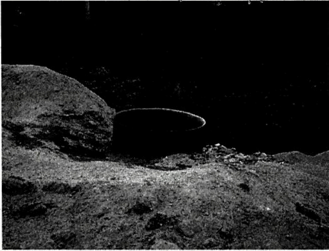
Foto 9 e 10: Drenos de gases com chama para queima do gás.
