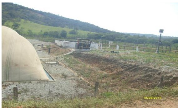
- Tanque recebimento efluentes.
