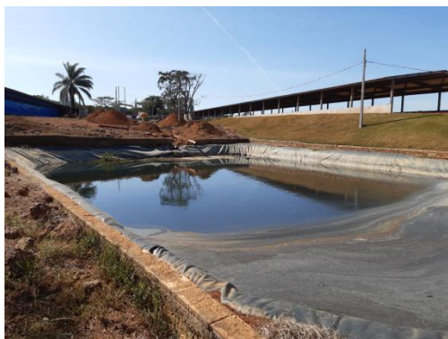
Foto 6. Lagoa de tratamento de dejetos suínos (em operação)
