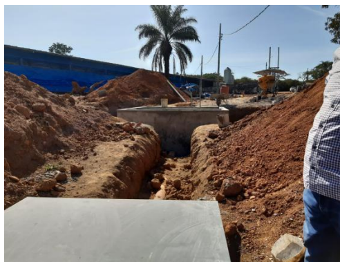
Foto 9. Sistema de drenagem de dejetos (em construção)
