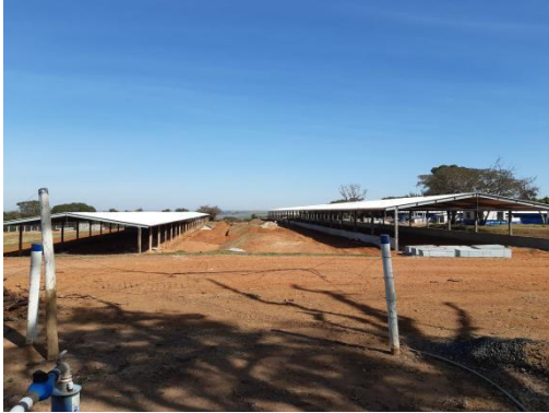
Figura 10. Galpões de criação de suínos (em construção)
