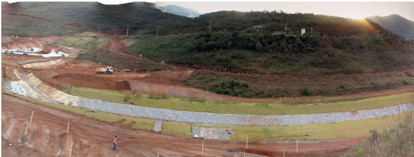
Dique da Oficina (descomissionado) e Dique de Macacos (Obras de adequação)
