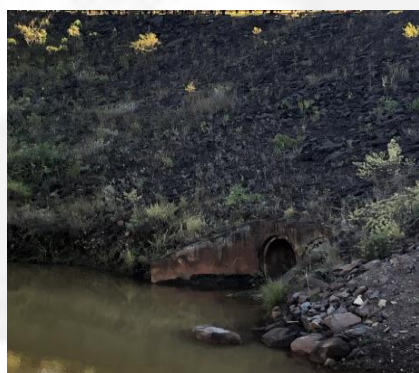
Foto 10 – Vista frontal de dois bueiros na bacia 18 que desagua no dique de Macacos ou dique B11.
