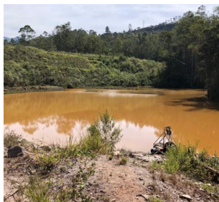
Foto 12 – Vista geral da bacia de Pinheirinho que tem um bueiro.
