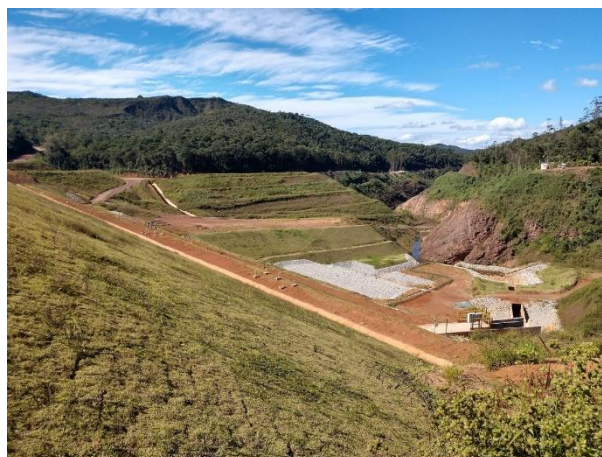
Nova Barragem de Santarém – Extravisor e Vertedouro
