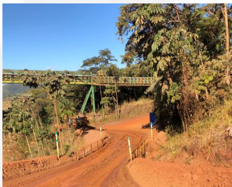
Foto 7 – Vista geral da travessia aérea para suporte da correia transportadora e da estrada passando sobre uma travessia (bueiro).
