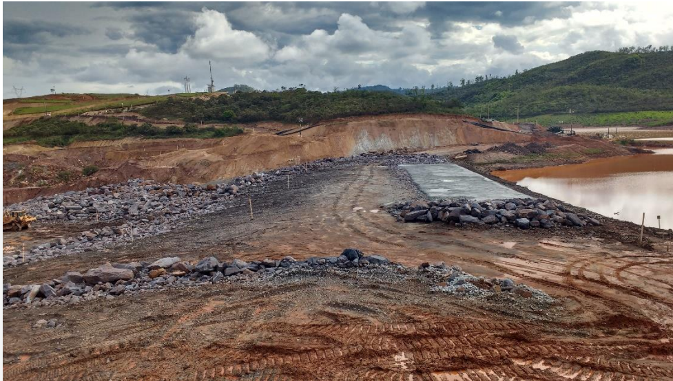
Figura 4.1 Implantação do Dique S3, novembro de 2016.
