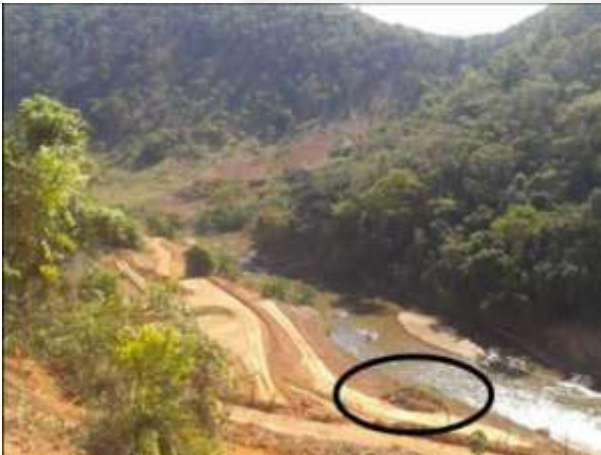
Foto 01 - Área do canteiro de obras, com a separação do Top Soil em destaque
