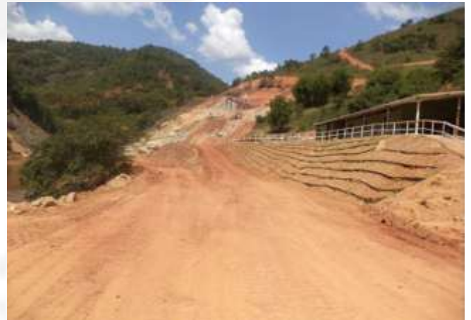
Foto 02 - Recuperação de outra área onde foi usado o Top Soil
