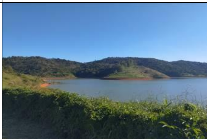
Foto 18: Barragem de rejeitos
