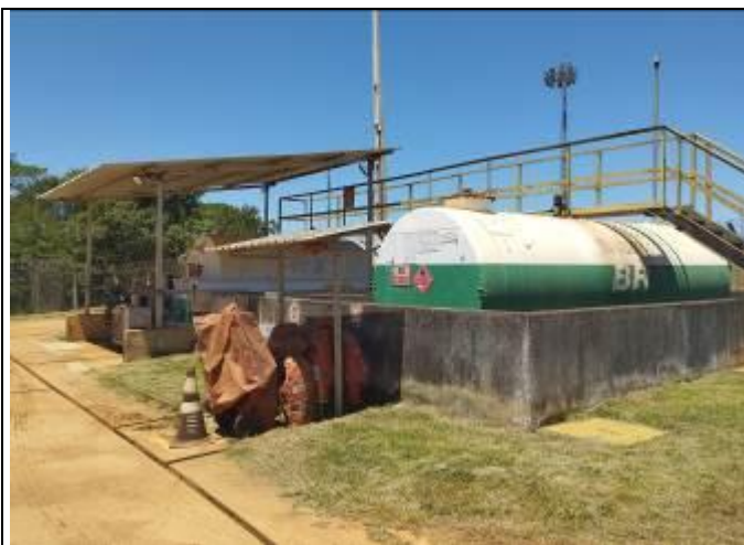
Foto 1: Posto de combustível
