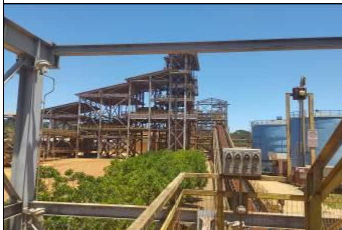
Foto 3: Vista lateral da UTM
