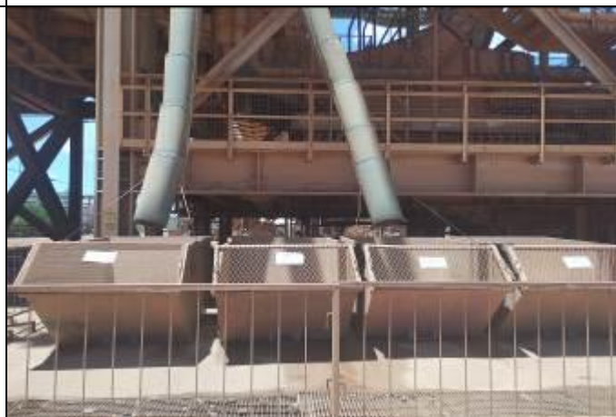
Foto 4: Recolhimento do minério para ser retornado ao processo
