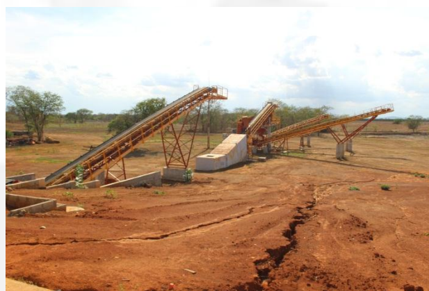
Foto 04. Unidade de beneficiamento com a parte mecânica já instalada. Notar erosões.
