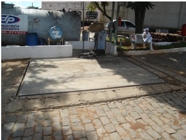
Foto 1: Área de abastecimento.
