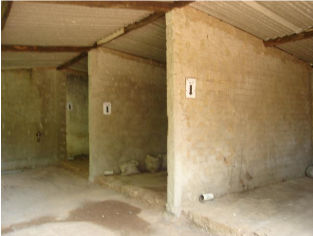
Foto 5: Depósito temporário de resíduos sólidos.
