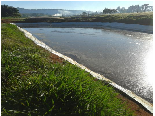
Foto 8: Vista da lagoa da ETE, após impermeabilização.
