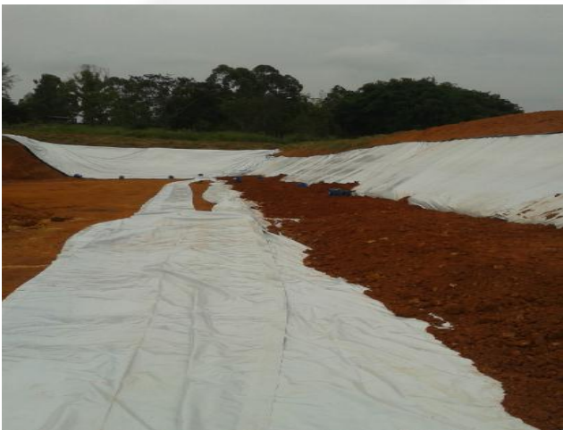
Foto 7: Impermeabilização da lagoa da ETE.
