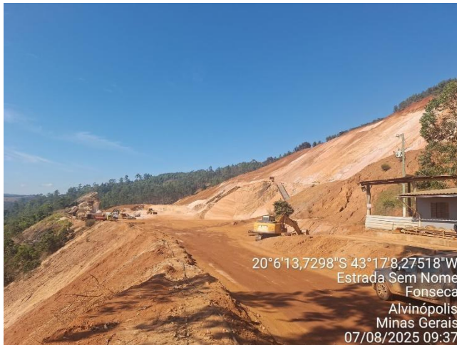
Foto 01. Visão geral do empreendimento.
