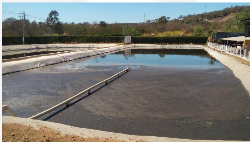
Foto 1: Estação de tratamento de efluente industrial
