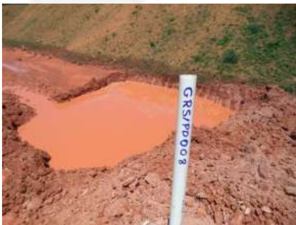
Figura 17: Poços de decantação.
