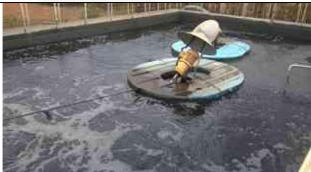
**Figura 15- Tanque de Aeração.**
