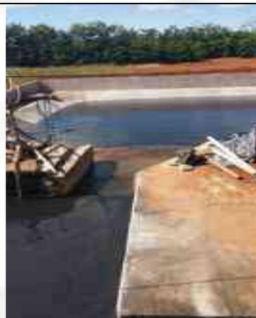
**Figura 16- Caixa de passagem e tanque pulmão construído.**
