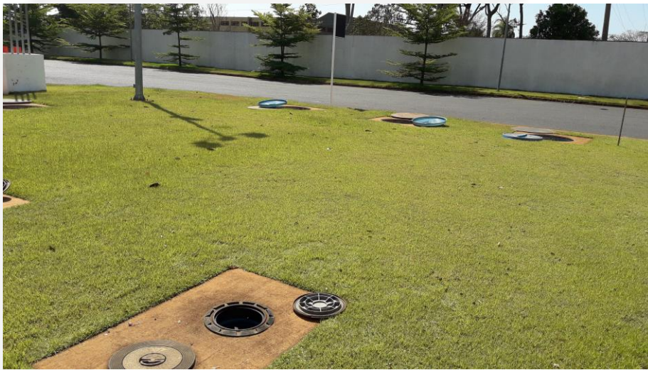
Foto 01. Área dos tanques
