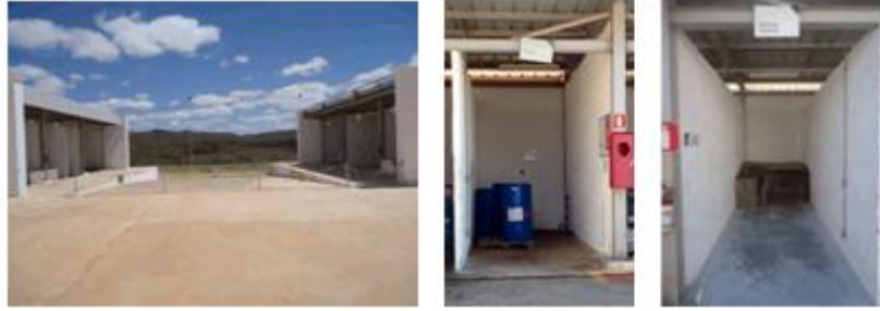
Foto 9: Galpão temporário de resíduos.
