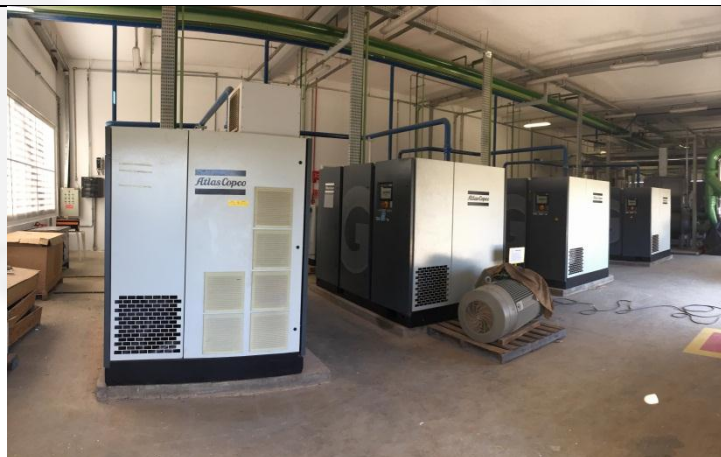
Foto 5: Área de Geradores.
