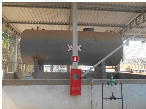
Foto 10. Área do tanque de abastecimento
