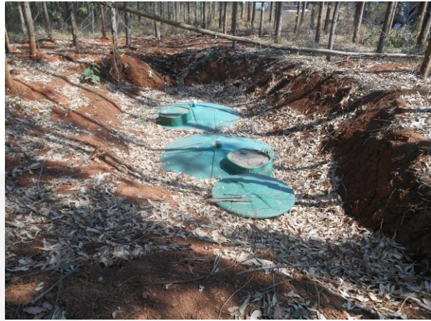
Foto 12. Estação de Tratamento de Esgoto - ETE
