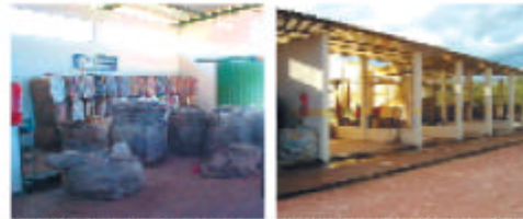
Galpão de armazenamento de recicláveis Baias de armazenamento de recicláveis
