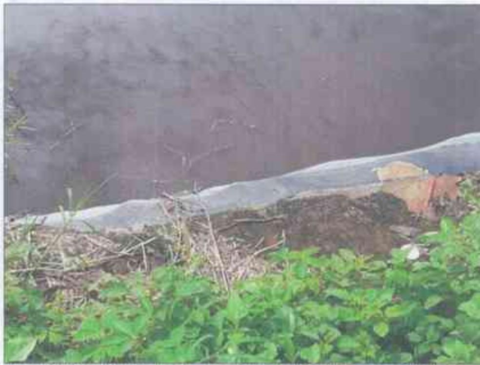
Figura 3. Vista da lona devidamente instalada na lagoa de estabilização.
