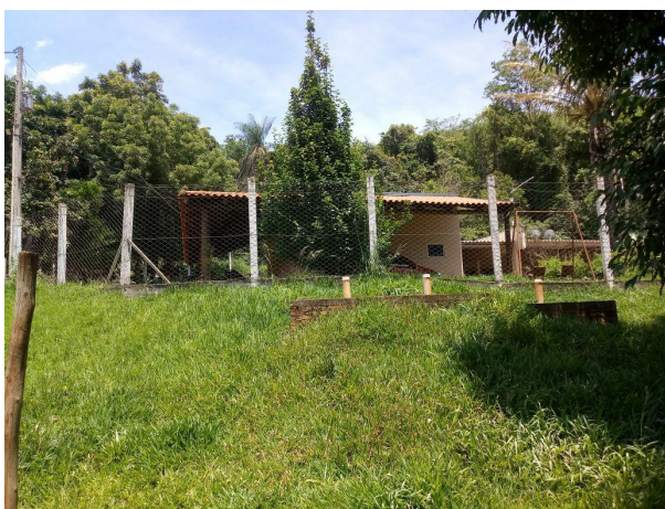
Foto 01. Casa sede e sistema de tratamento de efluentes fossa filtro sumidouro
