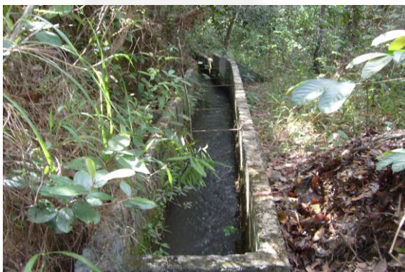
- Canal captação d'água
