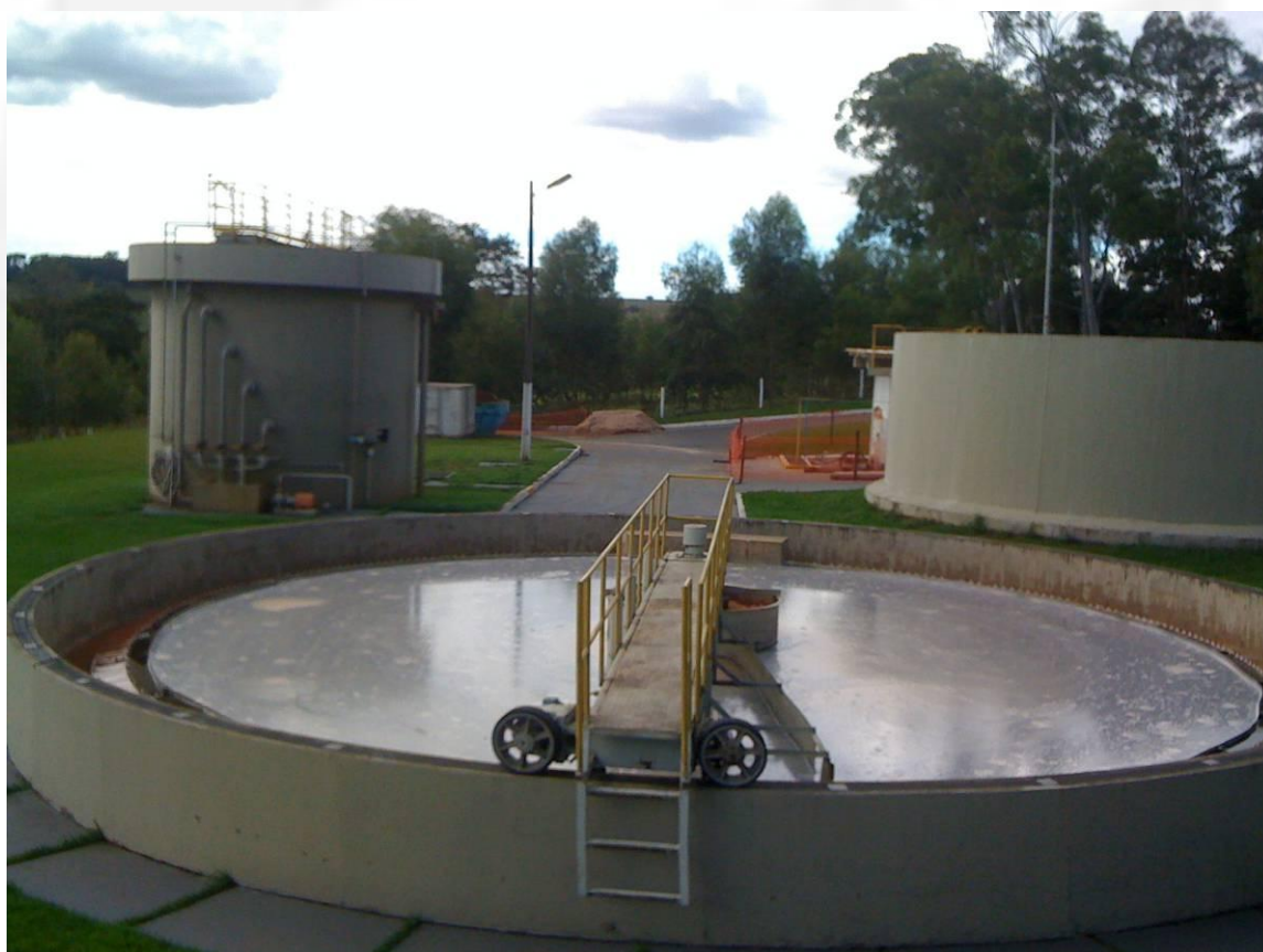
Foto 01: Vista do tanque clarificador (ao centro), tanque pulmão (direita) e tanque de lodo (esquerda). Fonte: SUPRAM TMAP, 2013.
