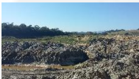
Foto 03. Deposição de material para recuperação da cava aluvionar.
