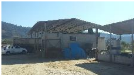
Foto 01. Galpão de manutenção e ponto de abastecimento.
