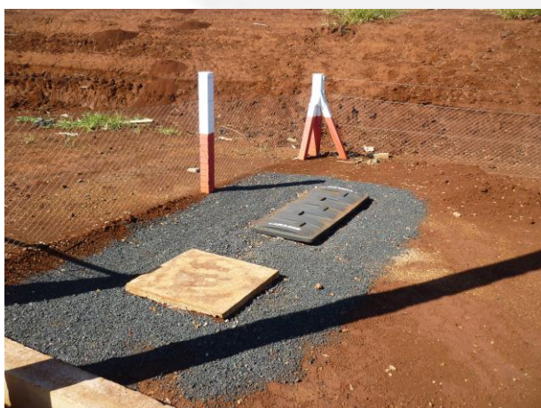
Foto 09. Caixa separadora de água e óleo
