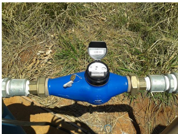
Foto 05. Hidrômetro do poço tubular
