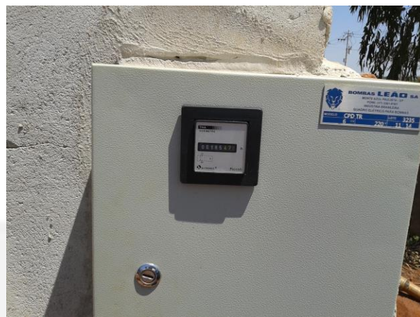
Foto 06. Horímetro do poço tubular
