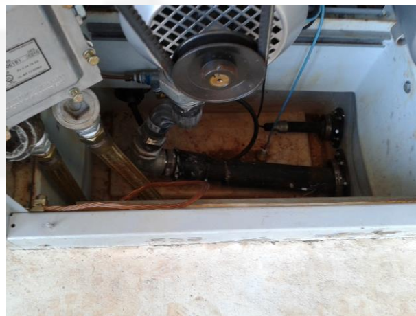
Foto 10. SUMP da bomba de abastecimento com monitoramento instalado
