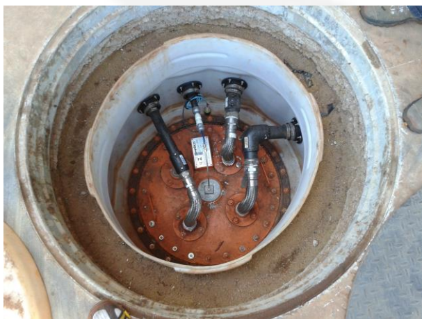
Foto 09. SUMP da boca de visita do tanque com monitoramento instalado
