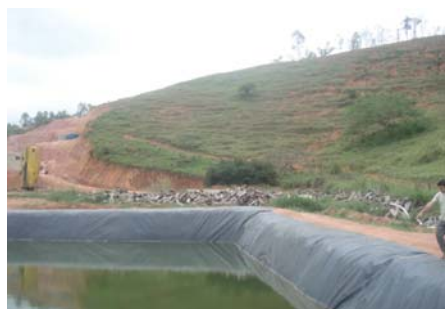
FOTO 1: Lagoa Aerada facultativa
