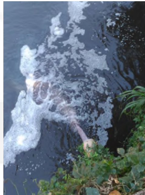
Foto 04. Lançamento do efluente tratado
