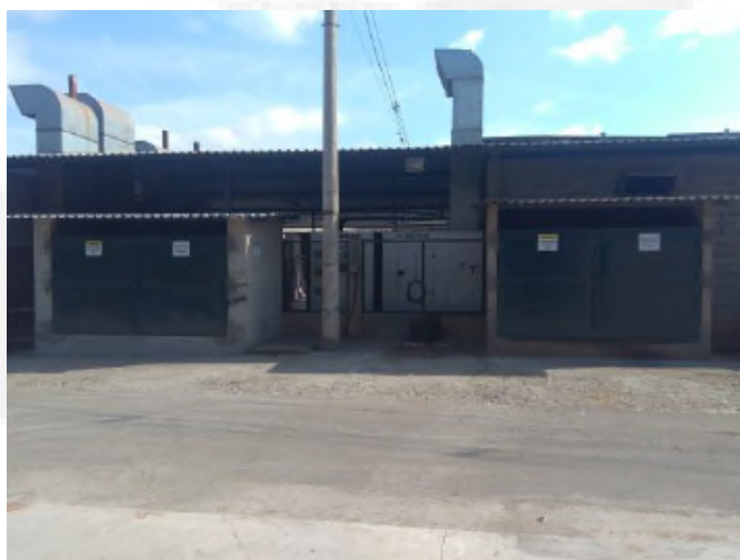
Foto 10. Galpão de armazenamento Resíduos Classe I
