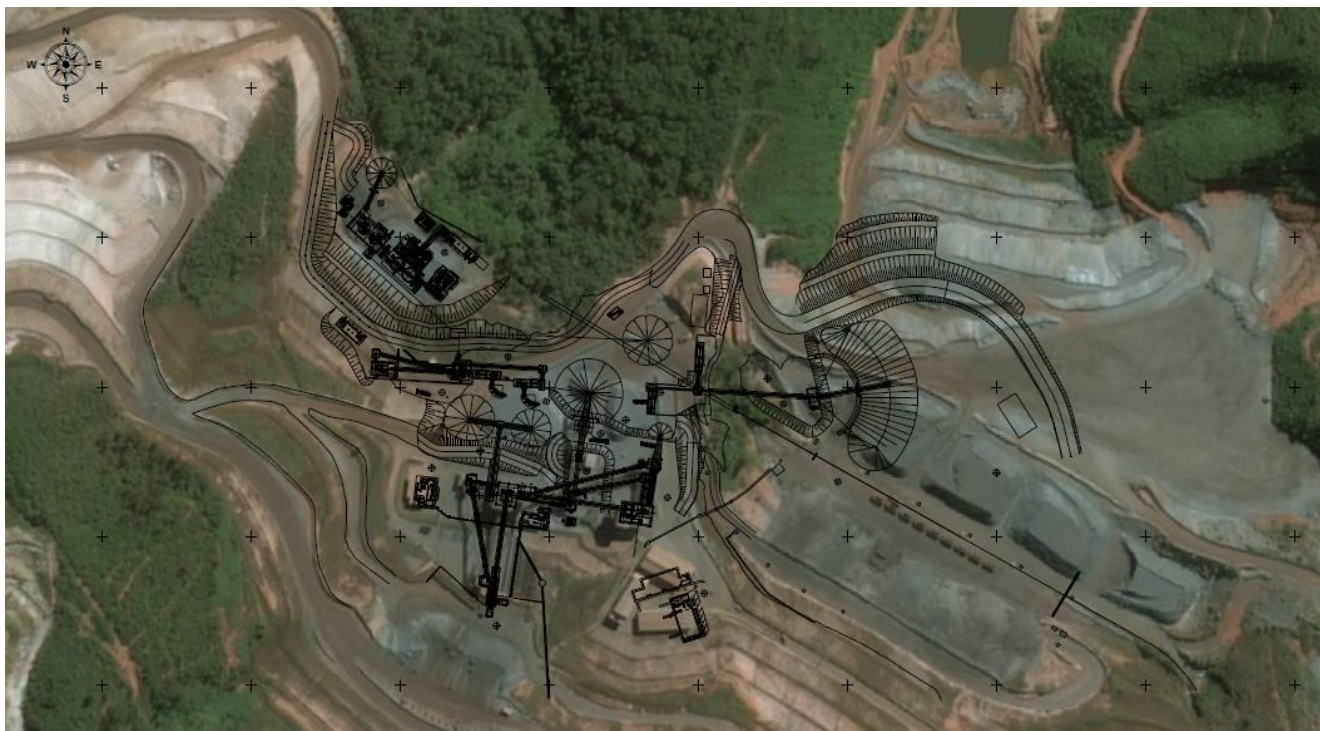
Foto 05: Arranjo geral da ampliação da UTM – Projeto Itabirito. Fonte: RCA (2018).
