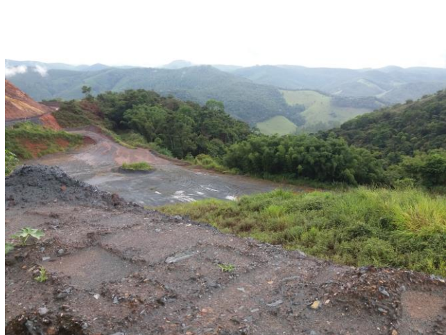
Foto 04: Área próxima à UTM existente em que será instalada a nova UTM.
