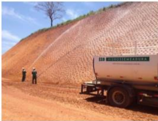
Figuras 08 e 09: Plantio por hidrossemeadura em talude e corte e Plantio por semeadura manual em talude de corte.
