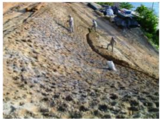
Figuras 08 e 09: Plantio por hidrossemeadura em talude e corte e Plantio por semeadura manual em talude de corte.
