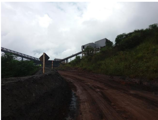
Foto 03: Estrada de acesso à UTM existente, que será utilizada na instalação da nova UTM.
