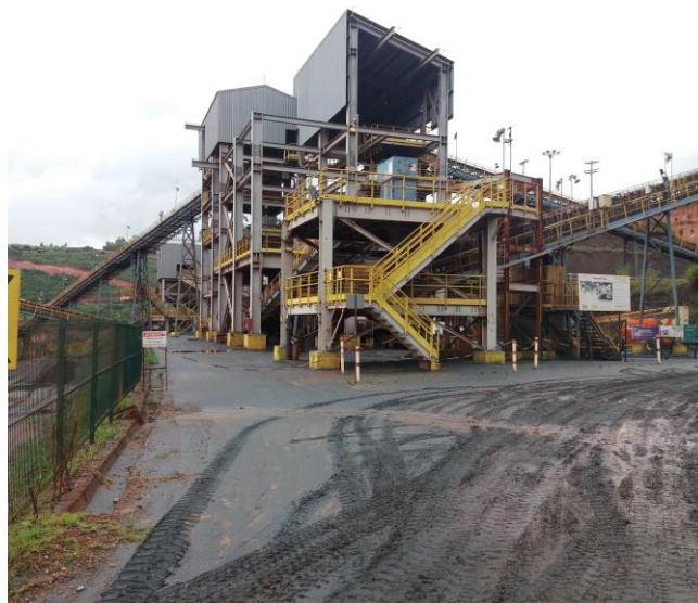
Foto 02: UTM existente da Mina do Andrade.
