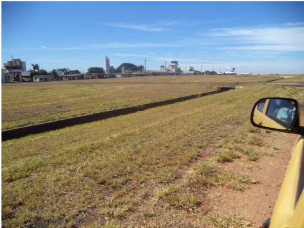
**Foto 05:** vista de vala para drenagem pluvial.
