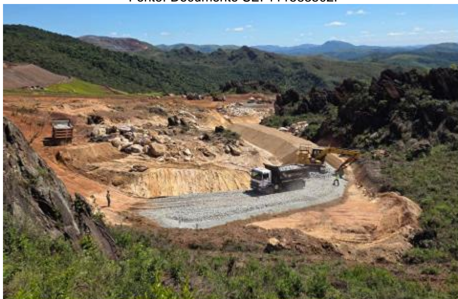
Figura 6. Drenagem interna – dreno tipo sanduíche. Fonte: Documento SEI 111583502.
