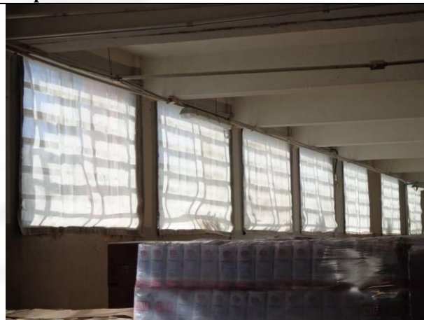
Figura 9 - Telas para controle de aves e retenção de material particulado
