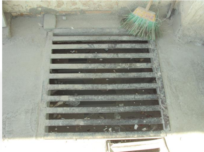
Figura 3. Caixa decantadora e canaleta de drenagem pluvial
