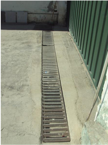
Figura 3. Caixa decantadora e canaleta de drenagem pluvial
