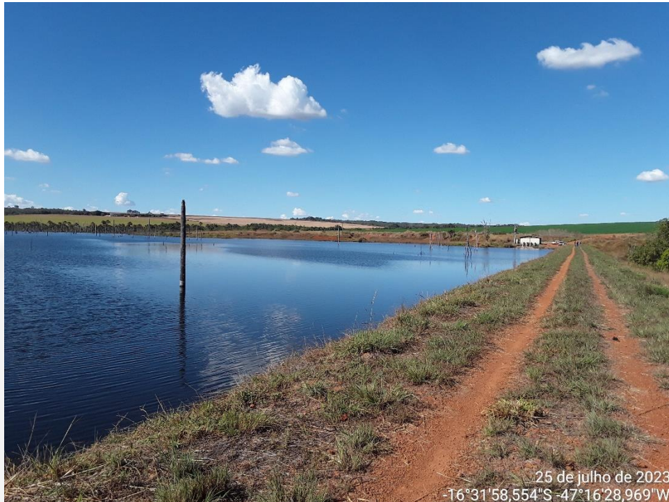
Foto 1 – Foto da Barragem B3 com presença de buritis na área inundada. Fonte: Foto tirada durante a vistoria.
