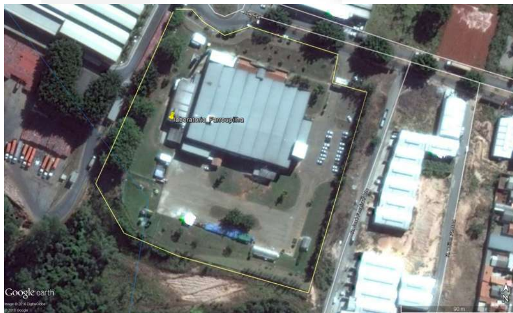
Figura 01. Vista aérea do empreendimento Fonte: Google Earth/2017
